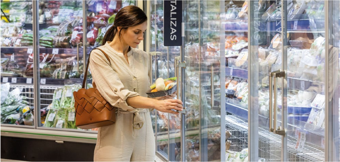
Eficiencia energética: cerramiento de cámaras de frío. Supermercado de El Corte Inglés de Pozuelo, Madrid.
